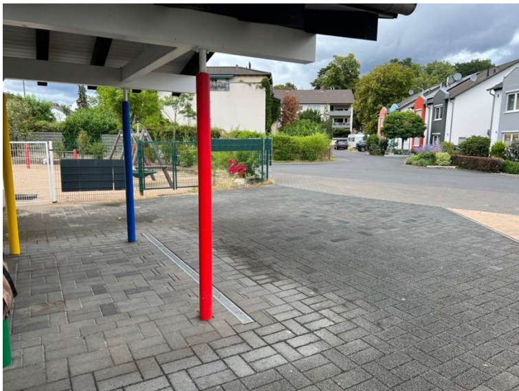
Abbildung 10: Ist-Situation Eingang und rechter Bereich
